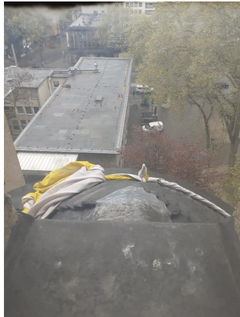
Alte Baumwollfahnen mit Rissen und kaputten Aufhängungen
